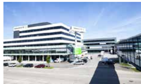
Ausbau der Zentrale in Wels
